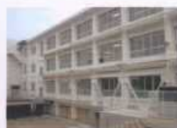
皇學館高校耐震補強 (楠部町)
