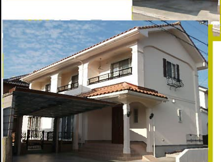
S邸 新築工事 (伊勢市)
